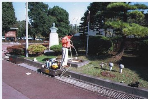
9. 吸水ホース投入
